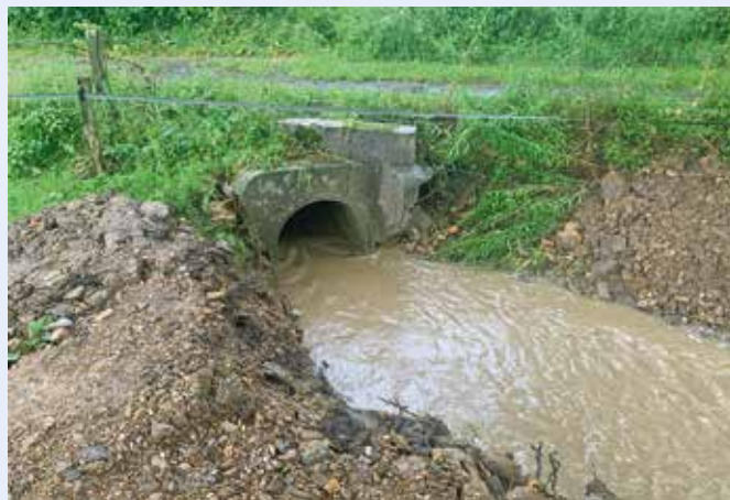
Durchlass am Vorfluter Kalfstraße in Roetgen.
