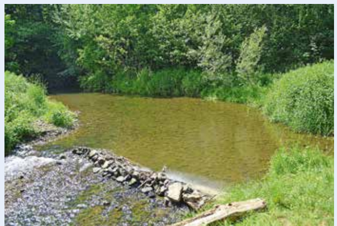
An der Inde bei Stolberg-Atsch gibt es bereits eine kleine Treibgutfalle. Diese ist an einer 90-Grad-Kurve der Inde angelegt. Angeschwemmte Gehölze werden in der Kurve durch die Strömung geradeaus weiter auf eine tieferliegende Freifläche geleitet, während das Wasser im Flussbett weiterfließt. Große Treibgutfallen funktionieren nach dem gleichen Prinzip, sie sind nur wesentlich größer.
