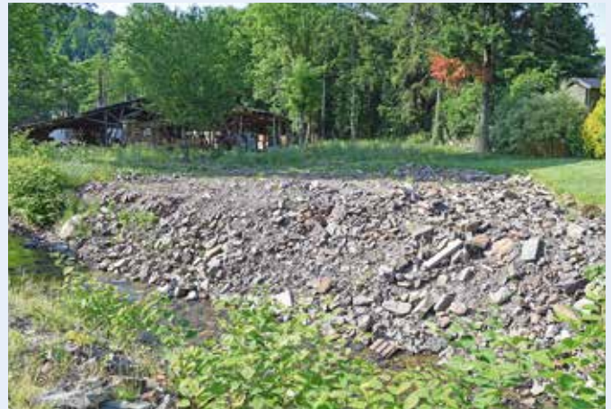
Der Hasselbach wird an dieser Stelle (wo derzeit die provisorische Böschungsaufschüttung liegt) aufgeweitet; daneben (rechts) wird der Abschlagsgraben angelegt. Das Betriebsgelände (oben links auf dem Bild) wird besser geschützt.
